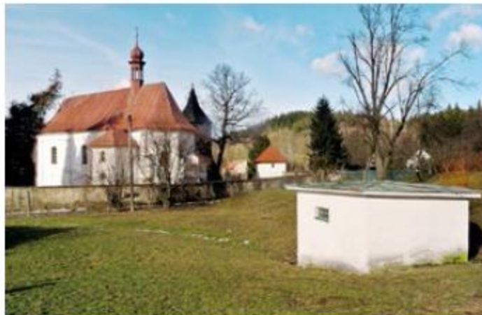
↑ Vodní zdroj – štola Kostel.
