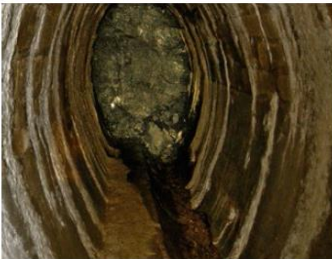
↑ Čelba v opukách ve štole s pramenními vývěry.
