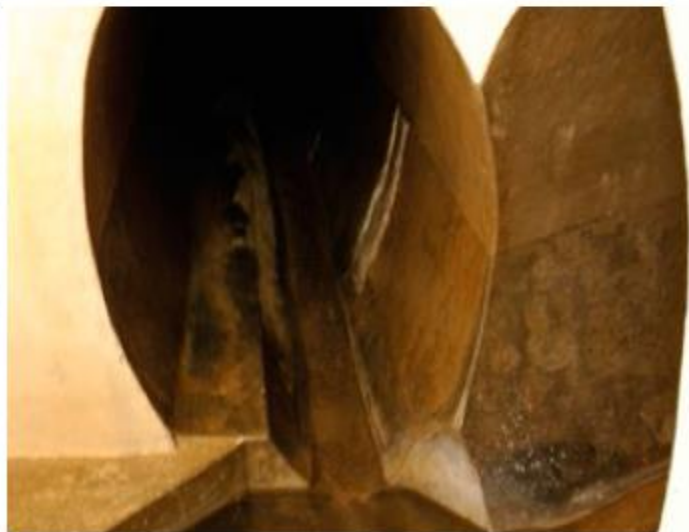
↑ Odvod pramenních vývěrů ve štole.
